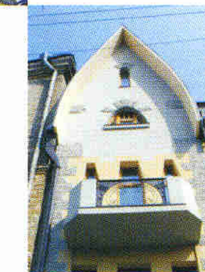
Реконструкция жилого дома в Чистом переулке
