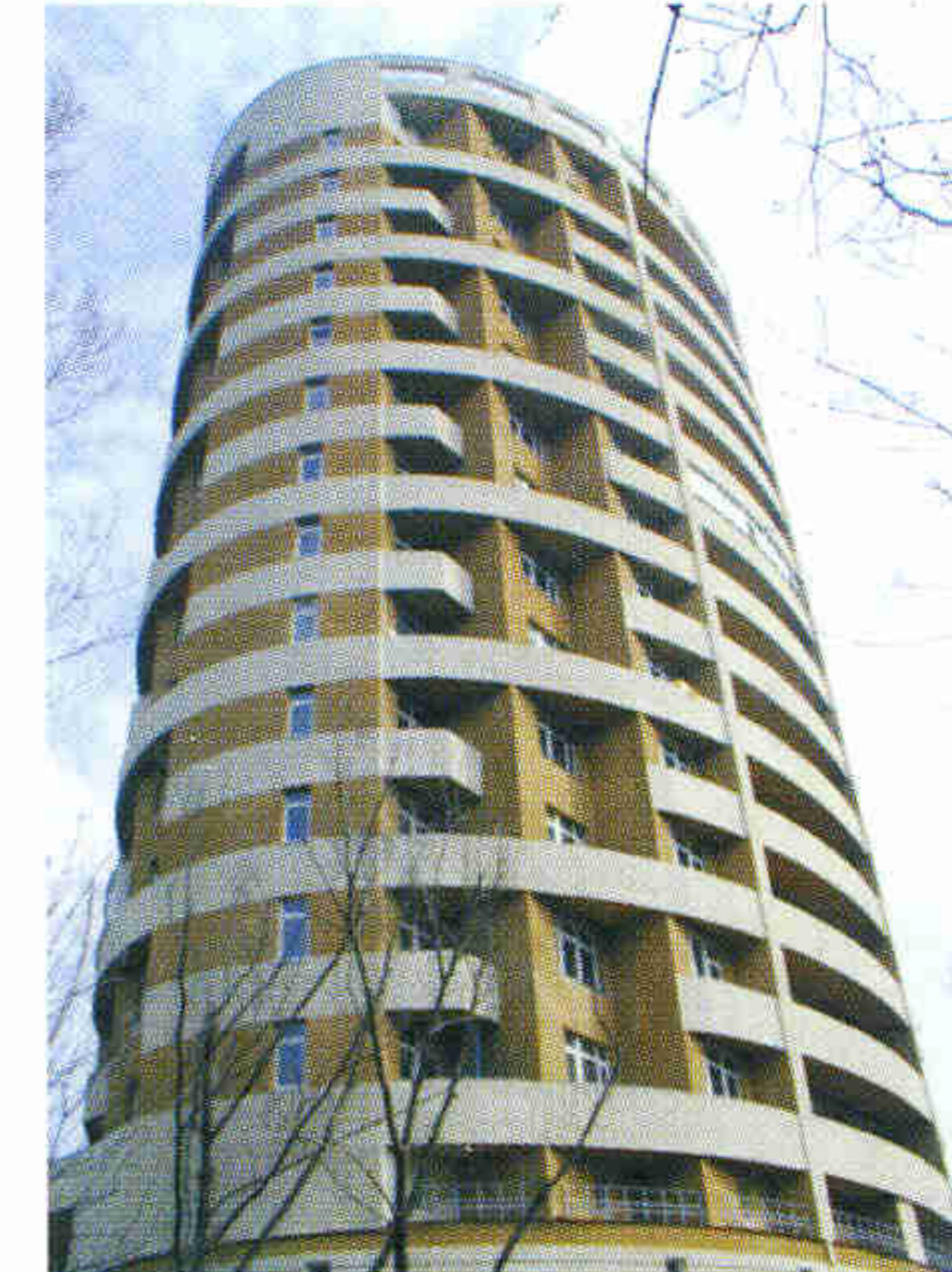
Жилой дом с гаражом-стоянкой на Ельнинской улице
